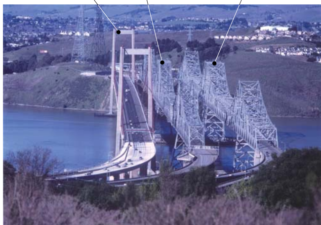
第 2 図 「ニューカルキネス橋」完成後の現場 Fig. 2 Site photo after completion of “New Carquinez Bridge”
