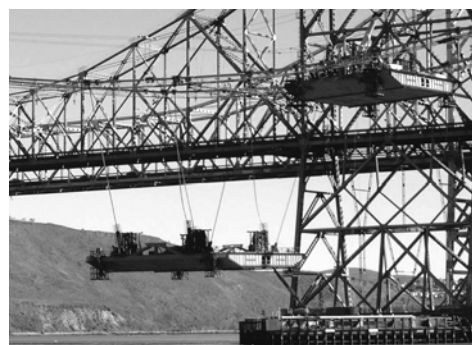
第14図 荷重移動による吊り下げ状態での桁横移動状況 Fig. 14 Traversing status of unit performed by load shifting under hoisted condition
