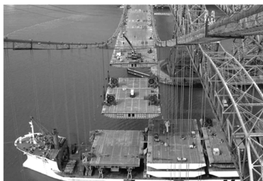
第13図 桁の架設状況 Fig. 13 Lifting up of unit
