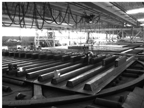
第 7 図 パネル組立溶接作業状況
