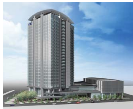
第1図 「豊洲 IHI ビル」全景 Fig.1 “TOYOSU IHI BUILDING”
