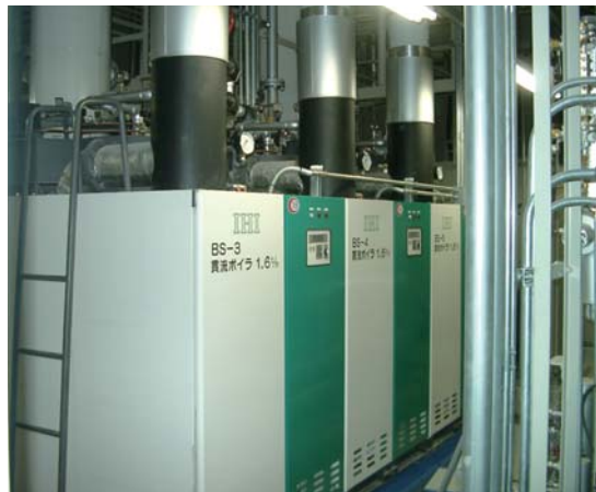
第 6 図 貫流ボイラ Fig. 6 Once-through boiler
