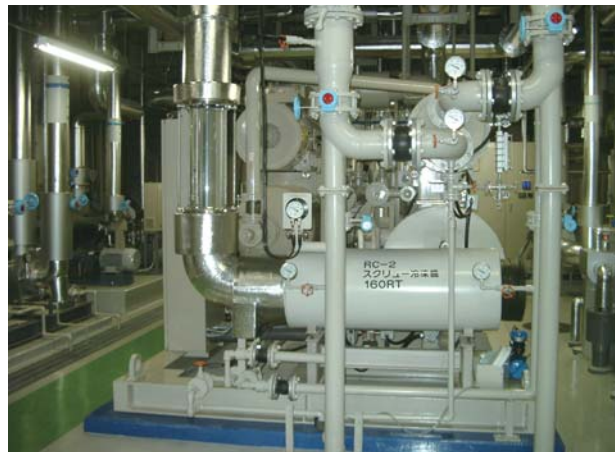
第 8 図 直接過冷却式氷蓄熱システム Fig. 8 Direct-type ice slurry storage system
