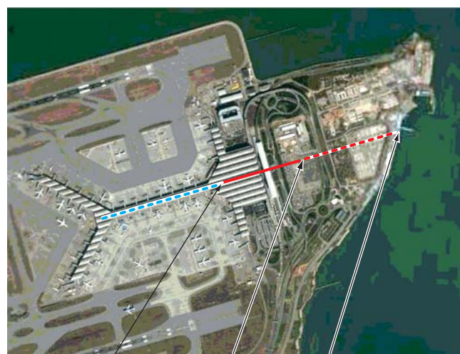
第 1 図 香港国際空港全景 ターミナルビル 1 “イーストホール” ターミナルビル 2 “スカイプラザ” フェリーターミナル “スカイピア” Google Earth より引用 (注) — : SKP 線 1 期 - - : SKP 線 2 期 - - - : 既設 PTB 線
