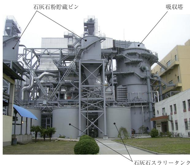
第 1 図 外高橋脱硫装置の全景
