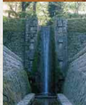
安積疏水完成時につくられた人工の滝「龍山の飛瀑」。単なる観賞用ではなく、製糸業の動力源として利用するために造られました。現在もその形をとどめ（写真下）、今年3月に、学術上貴重な近代建造物の保護を目的とした登録有形文化財に選定されました
