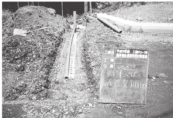
写真2 試験施工時の採水管設置状況について
