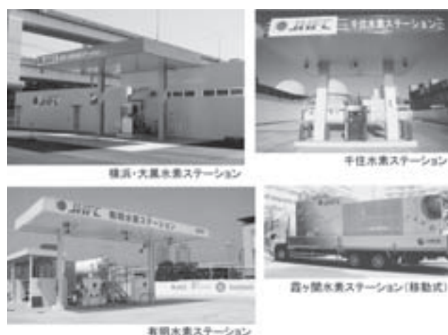
図2 水素ステーション
