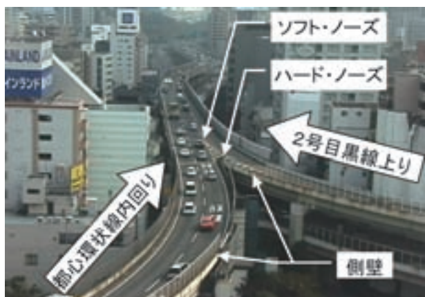
図1 首都高速道路一ノ橋ジャンクション
