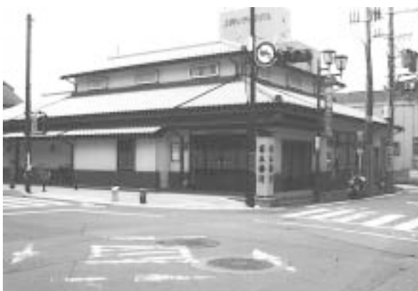
写真8 道路拡張のため建て替えられた百五銀行は瓦屋根、白漆喰、虫籠窓など伝統的なデザインを取り入れた。
