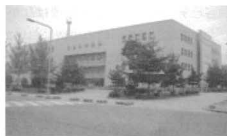
忠北大学校中央図書館・外観
