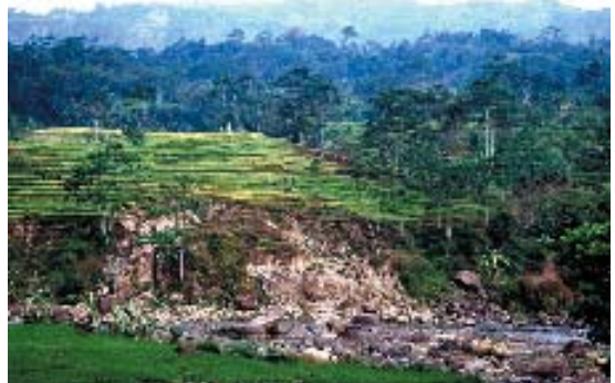
図6-2 地滑り地点の現地検証
