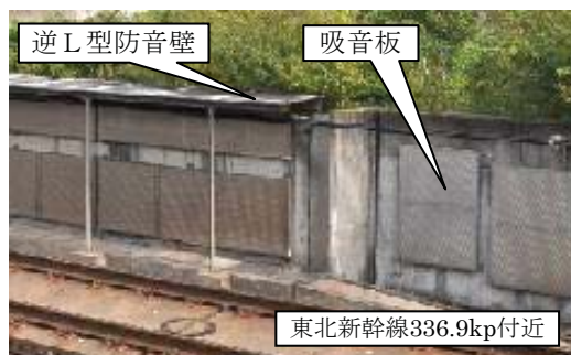
図2.2 逆L型防音壁と吸音板の設置状況
