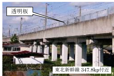
図2.3 嵩上げ防音壁（透明板）の設置状況
