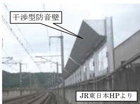
図2.4 干渉型防音壁の設置状況
