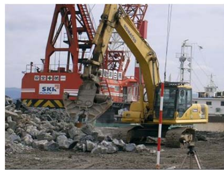
図 5-4 コンクリート圧砕機による桁破碎作業
