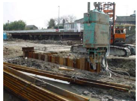
図 5-5 バイブロハンマによる鋼矢板吊り上げと打込み作業
