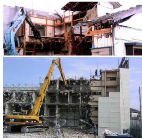
図 5-2 施工状況の全景
