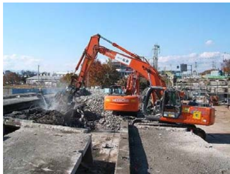
図 5-4 コンクリート圧砕機による桁破碎作業
