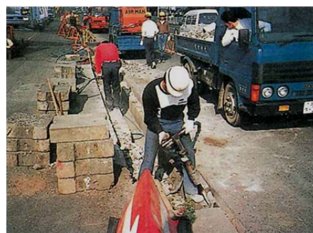
図 5-3 構造物の取り壊し作業
