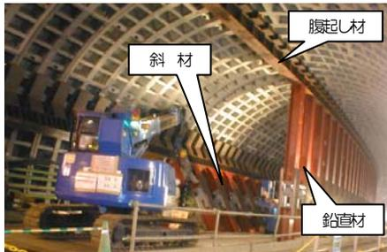
写真-2 内部支保工設置状況<sup>5)</sup>
