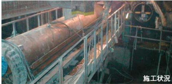
写真-1 パイプルーフ施工状況<sup>5)</sup>
