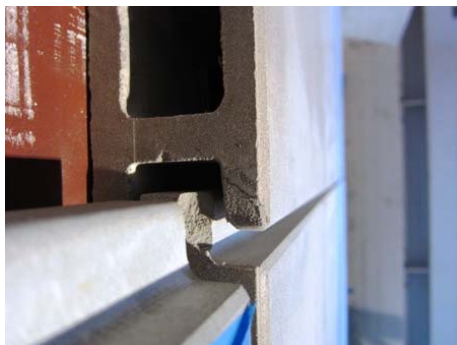
写真-6 セメント板施工状況
