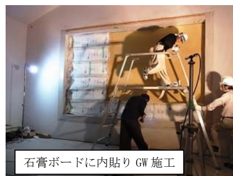
写真－４ 試験体施工風景
