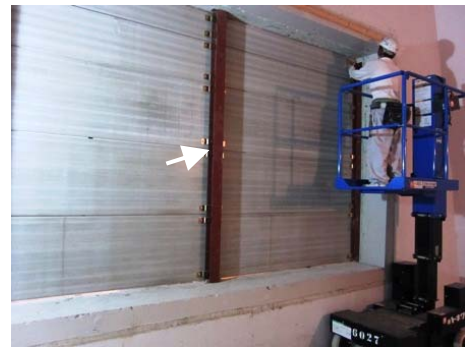
写真-7 セメント板施工状況
