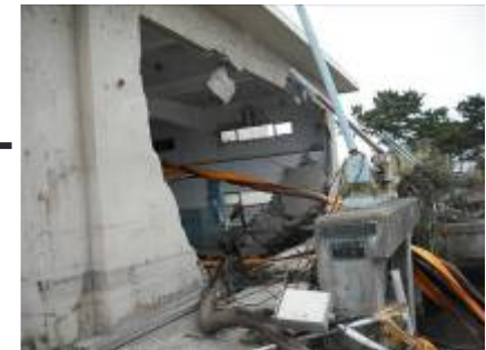
高砂南部排水機場
