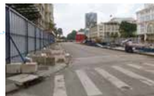
ホーチミン市。日本の ODA で地下鉄 1 号線の工事が始まりました。（2020 年に完成予定。地下鉄沿線を狙った開発が増えそうです。）
