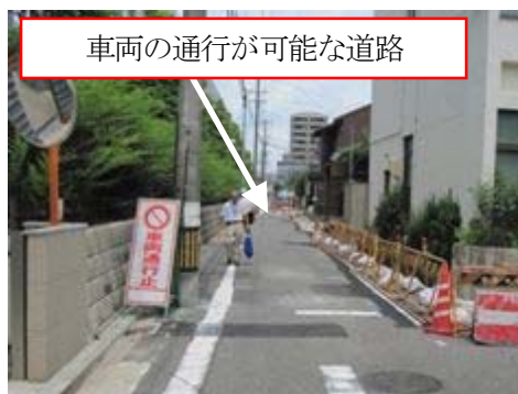
「車両通行止」標示板の設置状況
