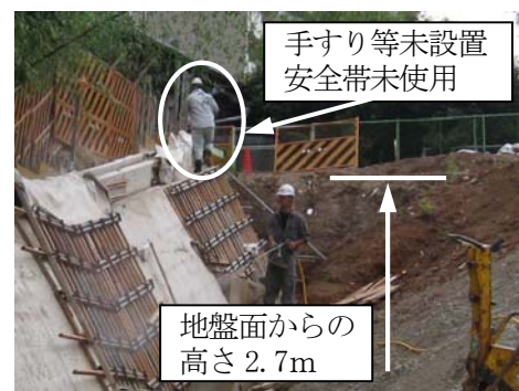
都計 3・5・118 池内猪高線街路築造工事（その 2）
