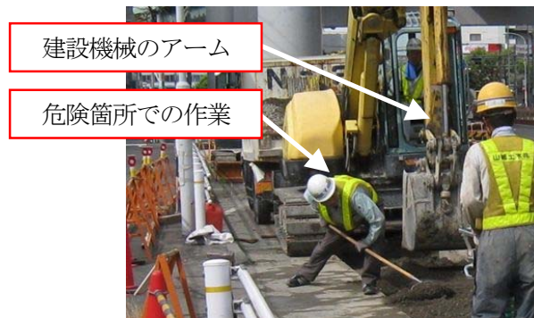
建設機械を使用する作業
