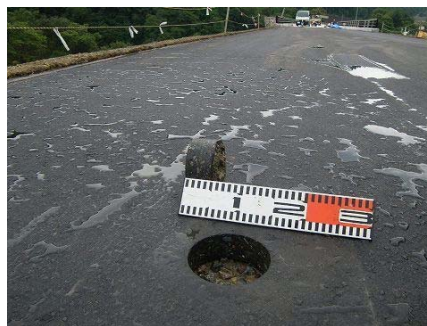
施工後の舗装から切り取られたコアの例
