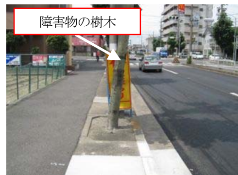
「段差あり」標示板の設置状況
