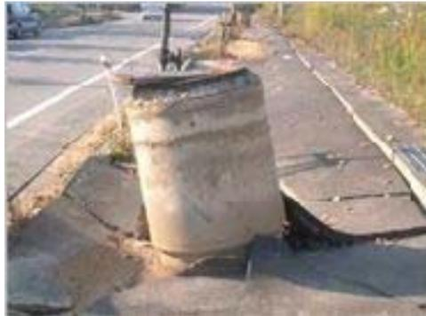
液状化によるマンホールの浮上被害の例
