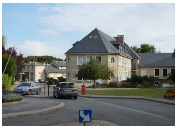
写真3 INRA ベルサイユの本部棟
