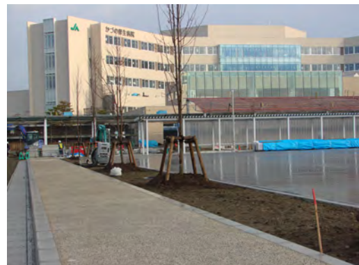
鹿角組合病院ラピリ舗装（舗装事例）
