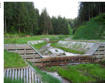
木製流路工(多自然型)特許第3477069号
