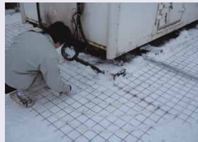
冷気循環パイプの敷設
