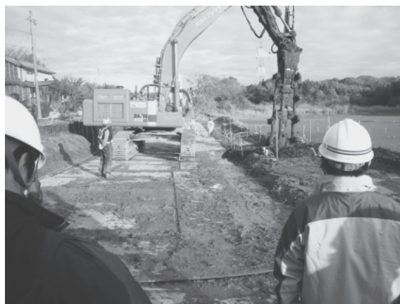
パワーブレンダー施工状況
