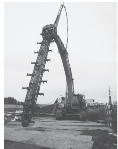
施工機械(1.9m 3 改造型BH)
