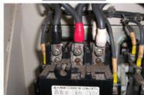
電磁接触器端子部
