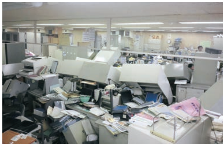
写真3-2 地震直後の市庁舎内部 〔3月11日 いわき市撮影〕
