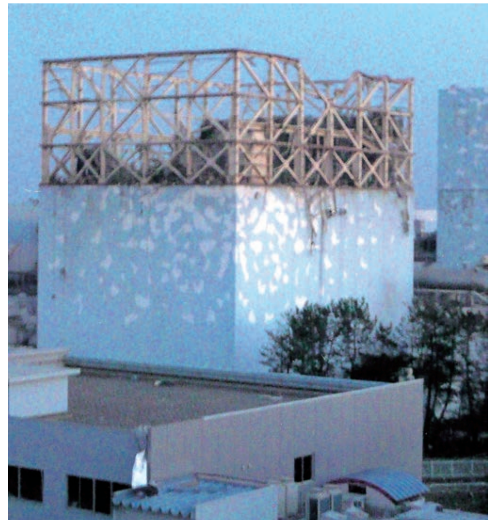
写真3-13 爆発した1号機 〔3月12日 東京電力㈱提供〕
