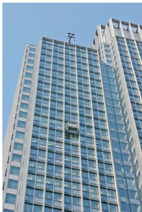
建物に合わせてオーダーメイドされる「ゴンドラシステム」
