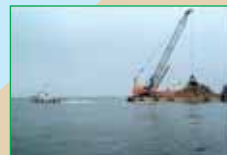
①人工リーフ設置作業
