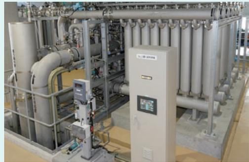
写真：浄水処理のための膜ろ過設備
