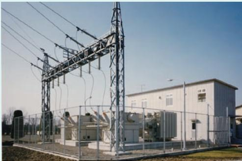
写真：プラントに電力を安定供給するための受変電設備
