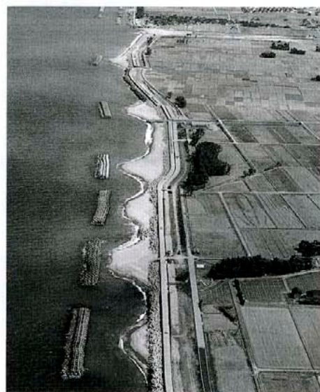
写真 - 離岸堤によってできたトンボ口
