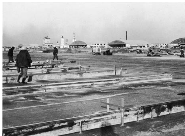
滑走路補強工事の様相 （『防衛庁飛行場工事の歩み』小川雷太著 航空新聞社刊）
