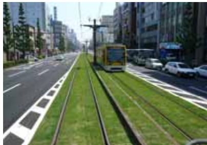
図2 市電の軌道敷緑化
