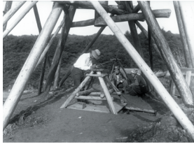
写真－8 エーデルン式 25m 基線尺による基線測量
