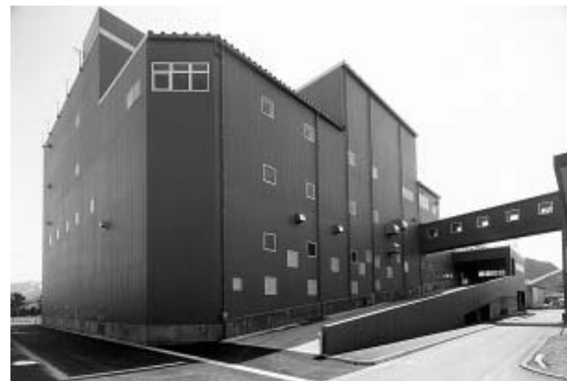
糸魚川地域広域行政組合 清掃センターごみ処理施設（炭化システム）
