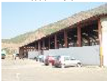
ヘソタンカ地域修理工場
