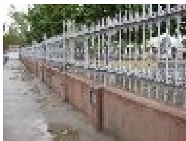
止水壁の設置
