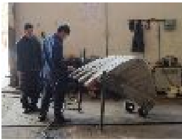
ヘソタンカ地域修理工場の溶接工
