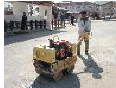
本案件によるハンドガイドローラを使った道路補修工事
