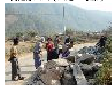
プナカ県フィーダー道路で石 を砕く作業員
