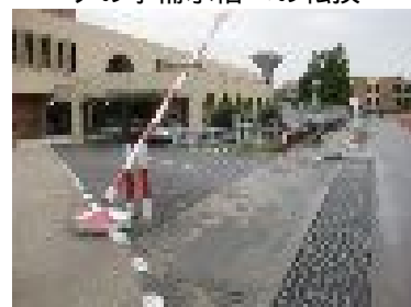
玄関前路面盤の切り下げと 雨水排水設備
