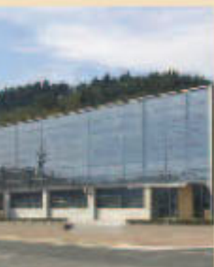
▲竣工間もないオフサイトセンター
