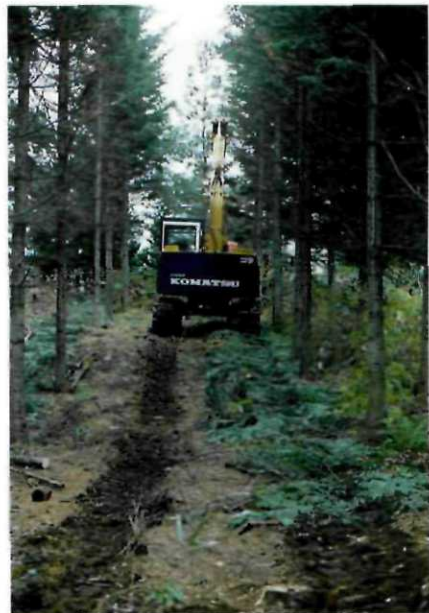
設定中の機械走行試験地
