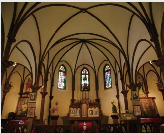
内部は木造。リブ・ヴォールト天井(コウモリ天井)が美しい
