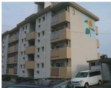
シラスバルーンペイント施工例
