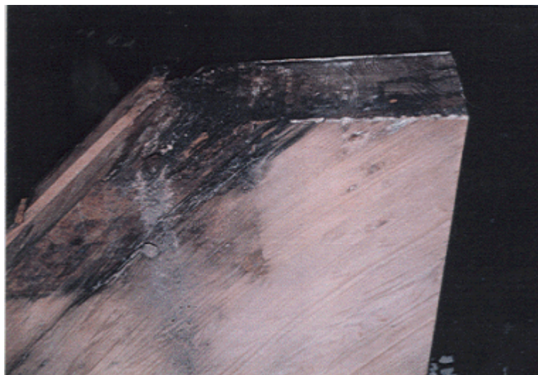
図 18 湾曲部の肩で鋼板が取り付けられていた箇所
