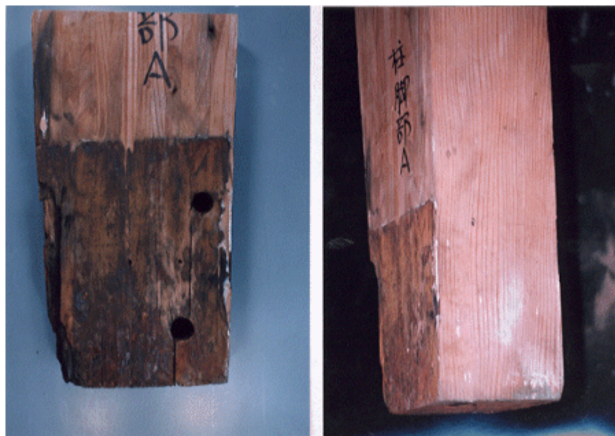
図 19 柱脚部の鋼板とボルトが取り付けられていた箇所
