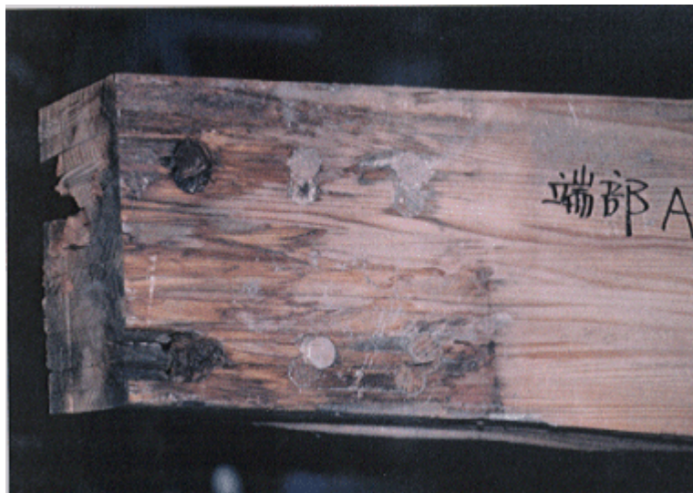
図 17 接合部鋼板が取り付けられていた箇所
