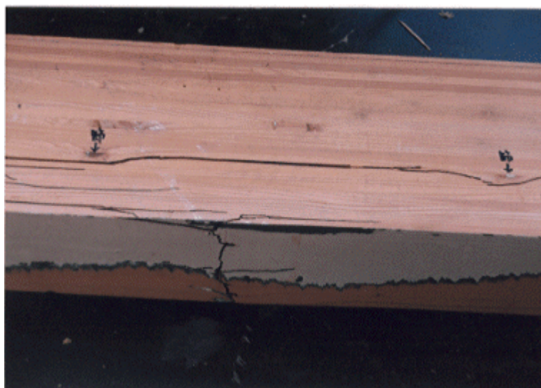
図6 集成材の側面と下面（引張り面）における破壊状況
