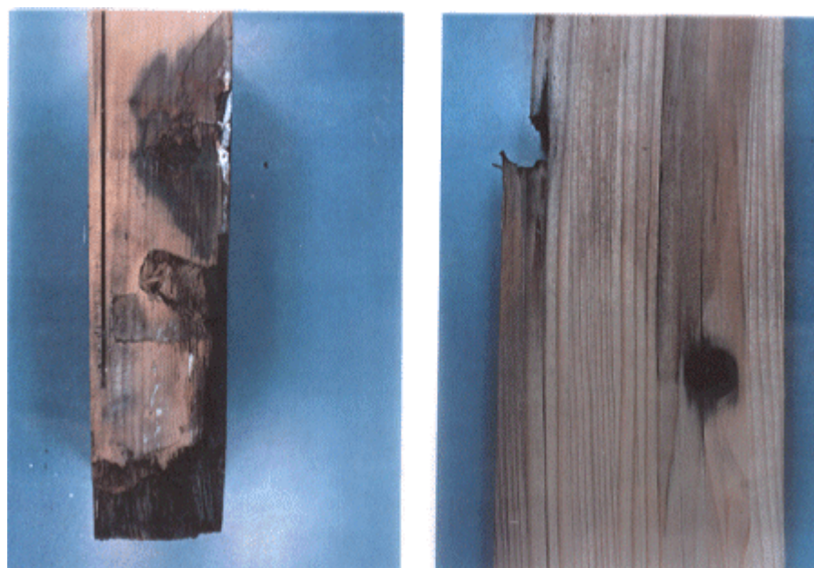
図 20 雨樋が取り付けられていた箇所
