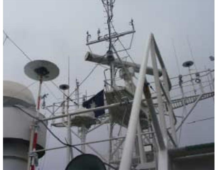
第1図 平成11年8月の相模湾航海の時に測量船「海洋」船上に取りつけられたGPSアンテナ。手前左側の丸い円盤と、奥のマストの上の左右に取り付けられた2つの円盤が、GPSアンテナのグランドプレーン。
