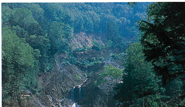
写真2 - 湯沢谷頭部の崩壊
