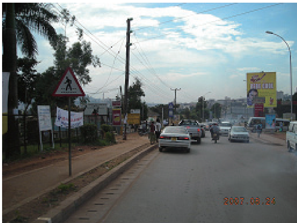
ガバ道路：車歩道分離帯、歩道及び交通標識の設置により歩行者の安全が向上した。また側溝の整備により降雨時の排水不良が改善された。
