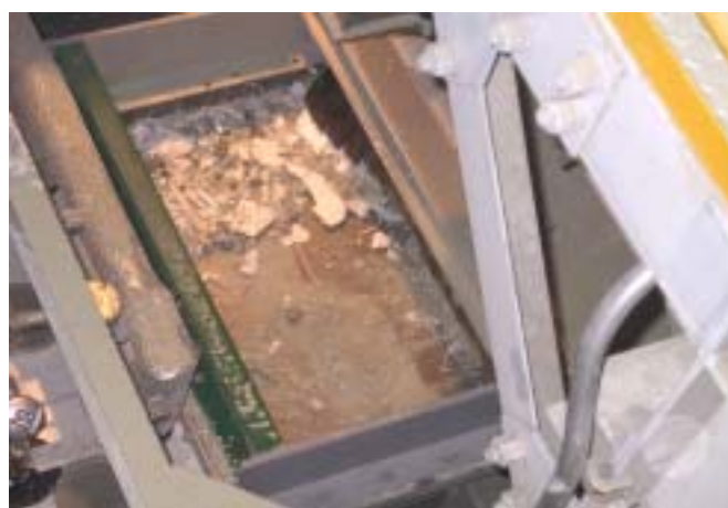
写真 7 冷蔵庫排出振動コンベヤ
