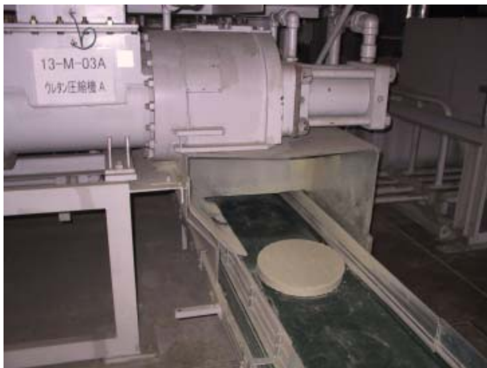
写真 10 ウレタン圧縮機と排出された成形ウレタン
