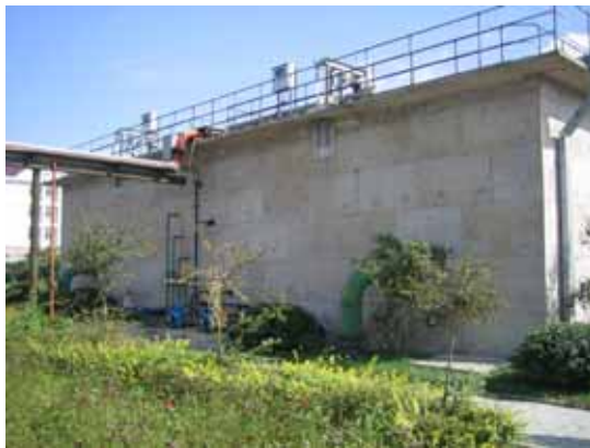
図 2. 4 4 汚水処理施設
