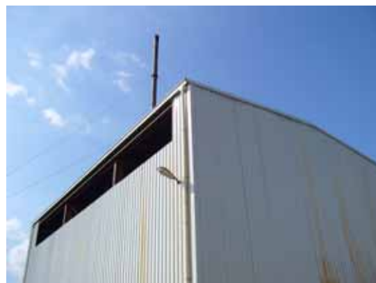
図 2. 3 3 旧型炉建屋外観
