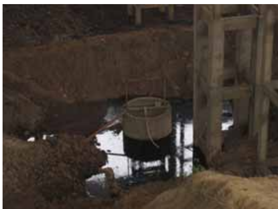
図 2. 3 8 処分場の底辺部
