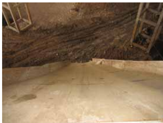
図 2. 3 9 処分物の投入口
