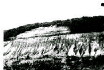
写真 - 2 海岸部の板状くずれ
