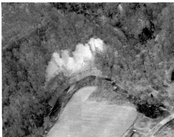
写真-1 表層崩壊タイプ
