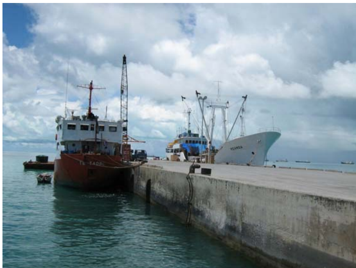
共用中の岸壁
