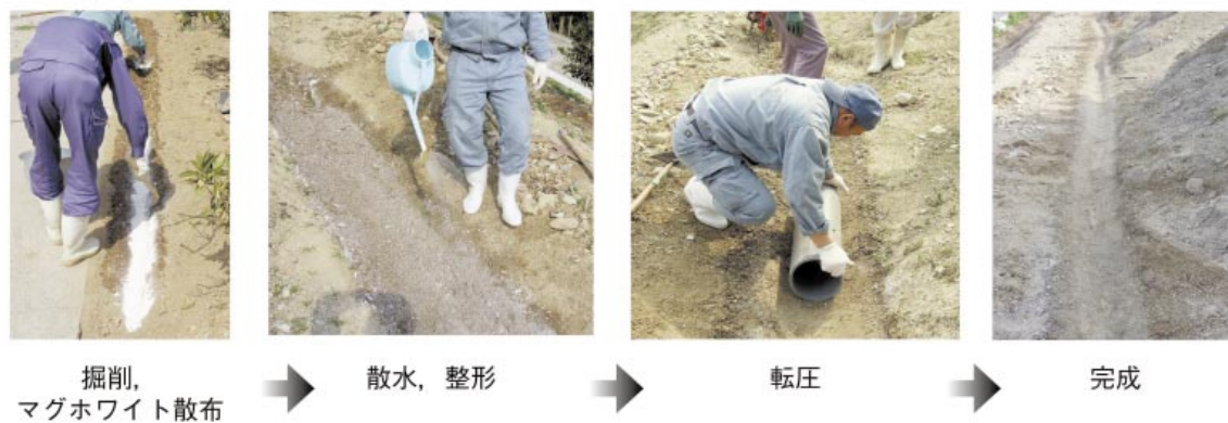
図2 マグホホワイトを利用した排水路の設置 （費用：約¥300/m・幅35cm・マグホホワイト使用量3kg/m）
