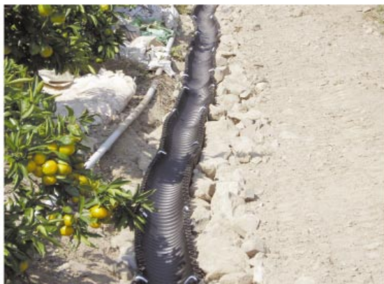
図3 プラスチックフリュームを利用した水路（費用：約¥1,700/m・幅25cm）
