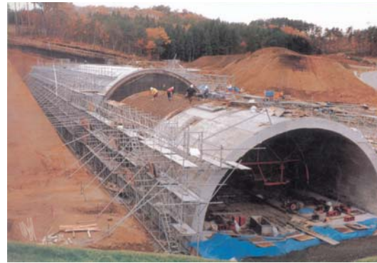
建設中の地上覆土式貯蔵庫
